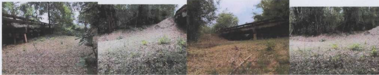
ภาพ ขณะดำเนินการ โครงการก่อสร้างลานคอนกรีต(คสล.) หมู่ที่ ๔ ห้วยบังขนิง บ้านวังกระเบา
