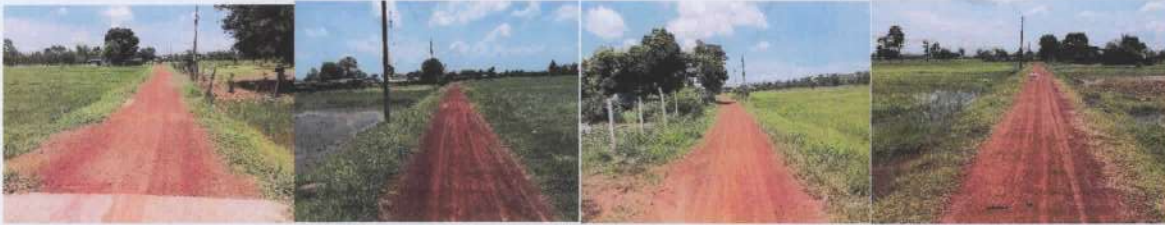
ภาพ ขณะดำเนินการ โครงการก่อสร้างถนนคอนกรีตเสริมเหล็ก (คสล.) สายบ้านนางรุ่งนภา ศรีสม บ้านนาสีนวล หมู่ที่ ๕
