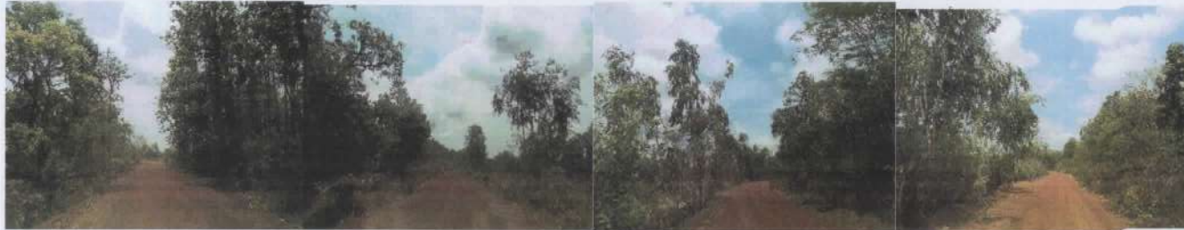
ภาพ ก่อนดำเนินการ โครงการก่อสร้างถนนคอนกรีตเสริมเหล็ก (คสล.) สายทาง สายถนน อบจ.ถึงสระนางเลิง บ้านโคกสว่าง หมู่ที่ ๘
